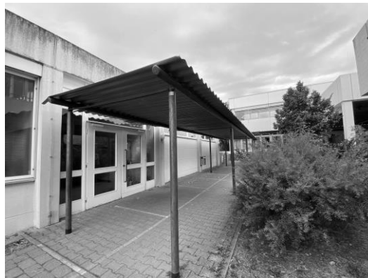
Innenhof zwischen West- und Südbau
