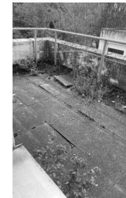
Klassenzimmer Balkone Hauptbau
